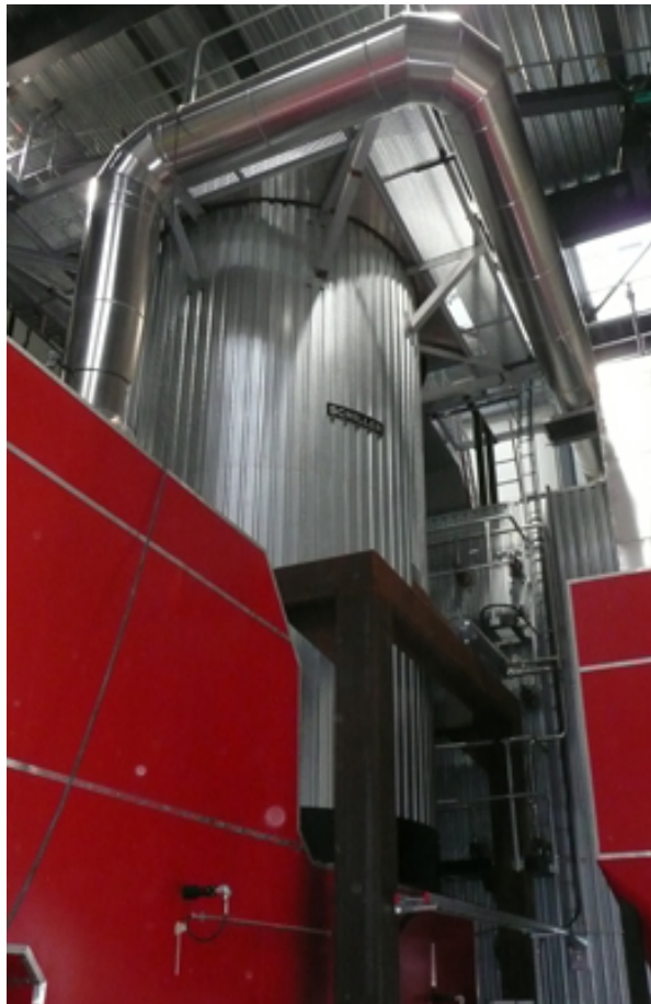
Foto 1: Rauchgaswärmetauscher einer Holzhackschnittzel-Feuerung.
